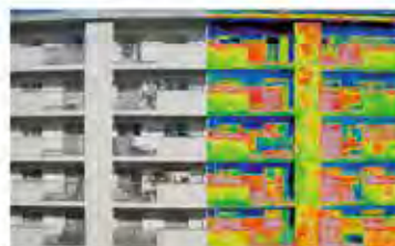
赤外線調査による外壁等劣化診断
